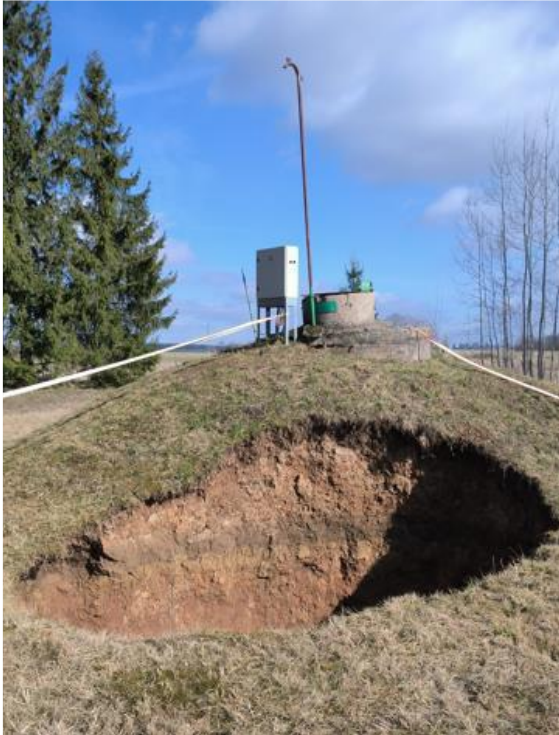
2 pav. Prie gręžinio atsivėrusi apie 7 m gylio įgriuva kėlė didelį pavojų inžineriniams statiniams ir buvo užpilta molingu gruntu jį sutankinant (kairėje nuotrauka UAB „Biržų vandenys“).
