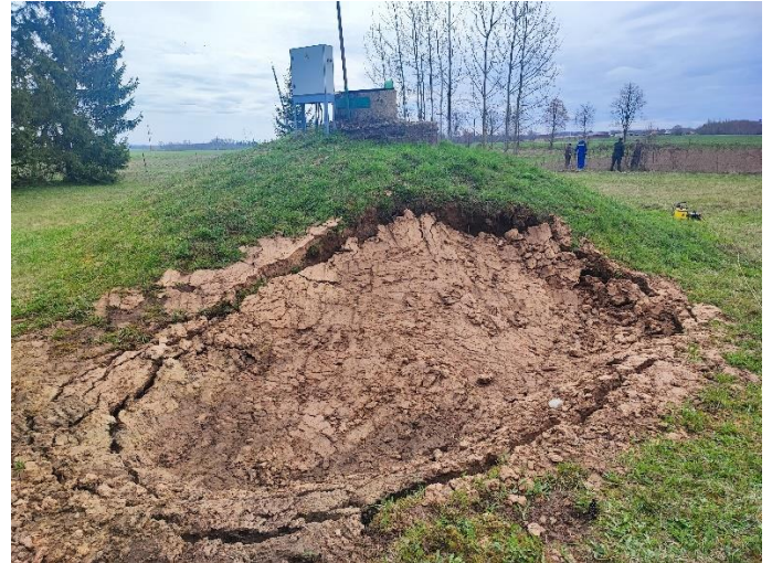
2 pav. Prie gręžinio atsivėrusi apie 7 m gylio įgriuva kėlė didelį pavojų inžineriniams statiniams ir buvo užpilta molingu gruntu jį sutankinant (kairėje nuotrauka UAB „Biržų vandenys“).
