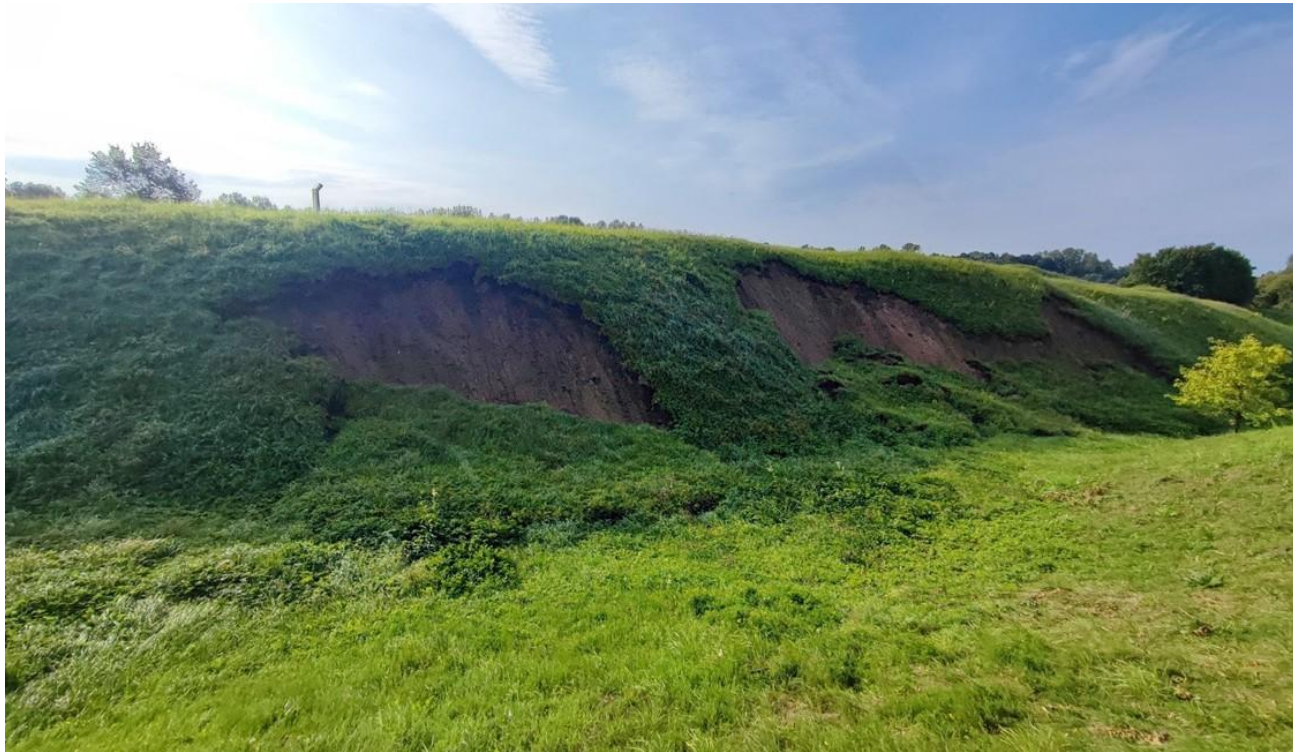
5 pav. Papilės II piliakalnio pietvakarinis šlaitas, pažeistas nuošliaužų
