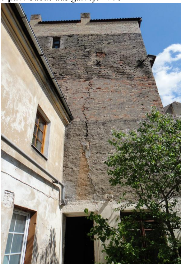
32 pav. Įtrūkusi pastato siena Paupio gatvėje Nr.9
