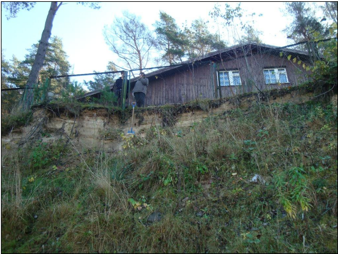
23 pav. Turniškėse nuo eroduojamo šlaito viršutinės briaunos iki namo likęs 9,7 m atstumas, kuris po pavasario potvynių kasmet sumažėja maždaug po 1,0 m.
