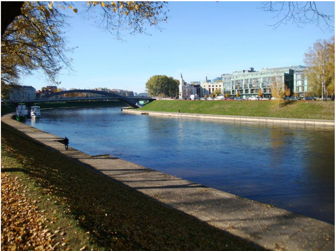
21 pav. Neries krantinės prie Mindaugo tilto ir sutvirtinti aukščiau esantys šlaitai
