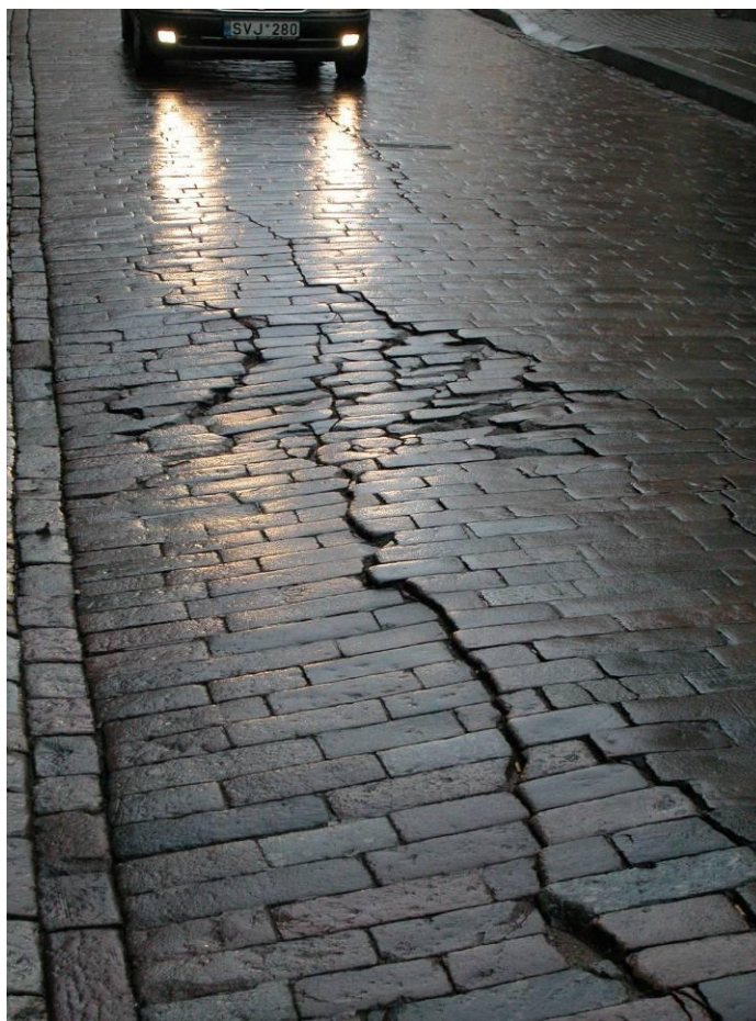
27 pav. Trūkės akmeninis grindinys Trakų gatvėje
