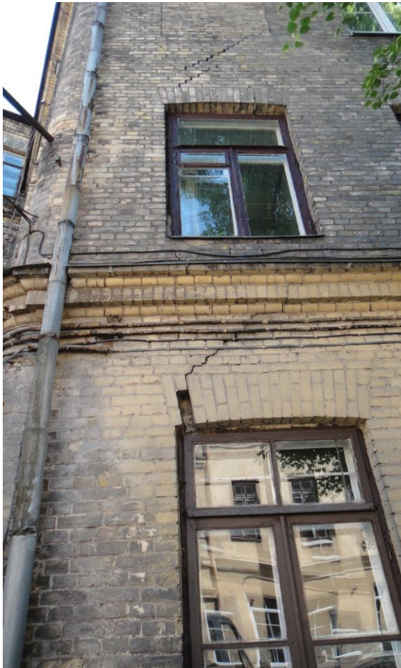
28 pav. Pastato deformacija Islandijos gatvėje Nr. 4
