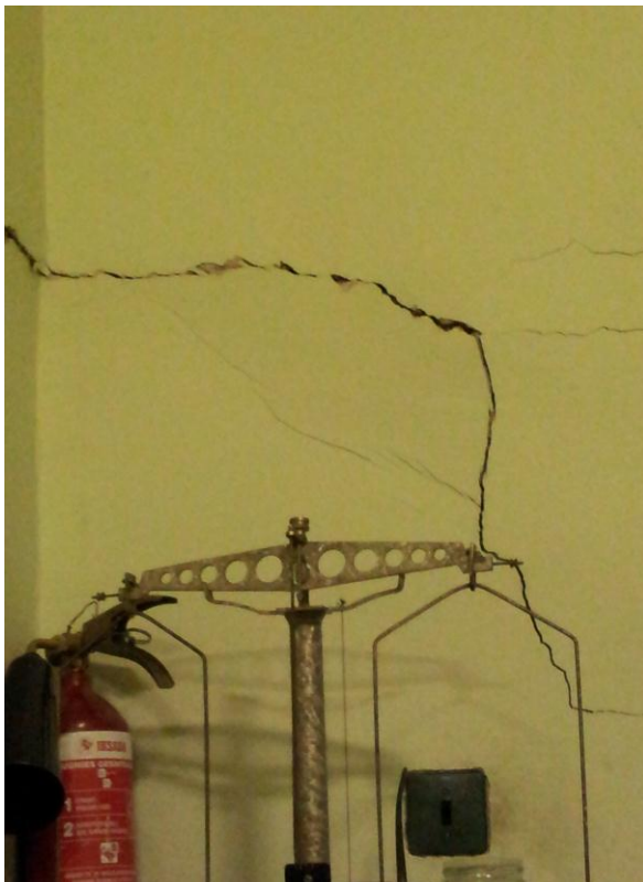
36, 37 pav. Vrublevskių bibliotekos įtrūkusios pastato sienos
