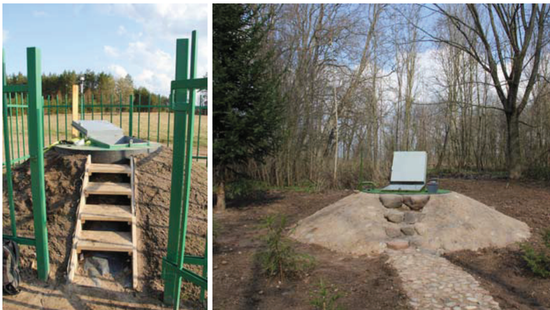
1 pav. Kairėje: PBUR seisminių stebėjimų stoties požeminė patalpa Paburgės kaime, Plungės raj. Dešinėje: PABE seisminių stebėjimų stoties požeminė patalpa „1963 metų sukilimo muziejaus“ teritorijoje Paberžės kaime, Kėdainių raj. (J. Čyžienės nuotr.)
