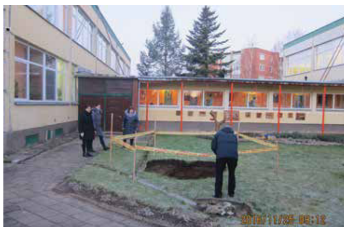
7 pav. Pasvalyje vaikų darželio kieme ankstų rytą atsivėrusi karstinė įgriuva išgąsdino darbuotojus ir pridarė žalos inžineriniams tinklams (A. Balčiūnaitis nuotr.)
