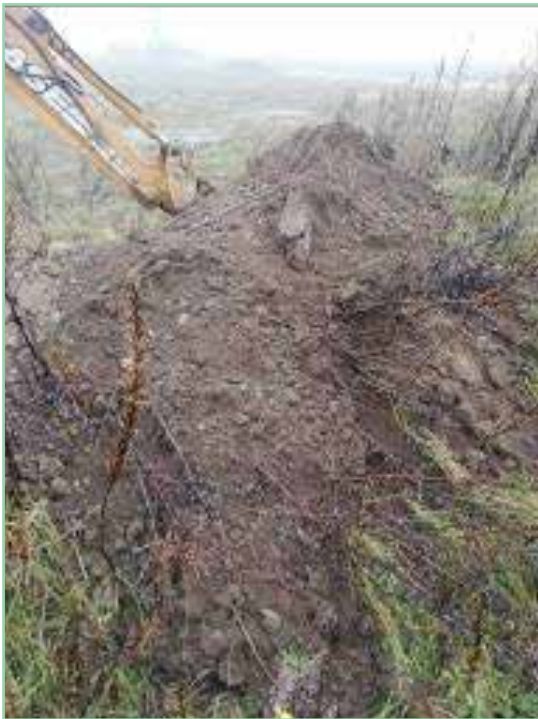
6 pav. Išilgai profilio (4 pav.) ekskavatoriaus iškastos statybinės atliekos.
