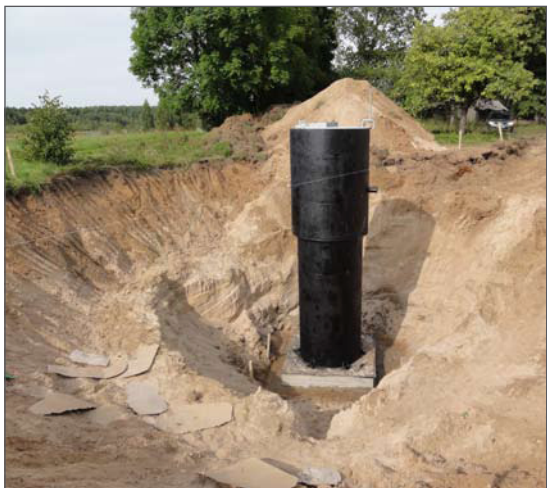
3 pav. Paburgės (PBUR) seisminių stebėjimų stotis: a) seisminių stebėjimų stoties statyba; b) seisminių stebėjimų įranga – jutiklis (sensorius)
