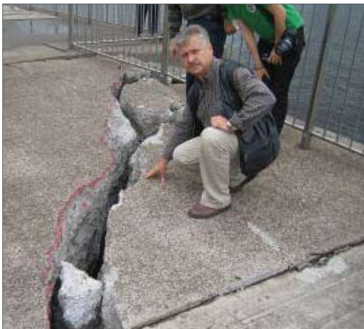
1 pav. (B) Krantinių plyšiai Chiba prefektūroje po 2011 m. kovo 11 d. žemės drebėjimo (Japonija)
